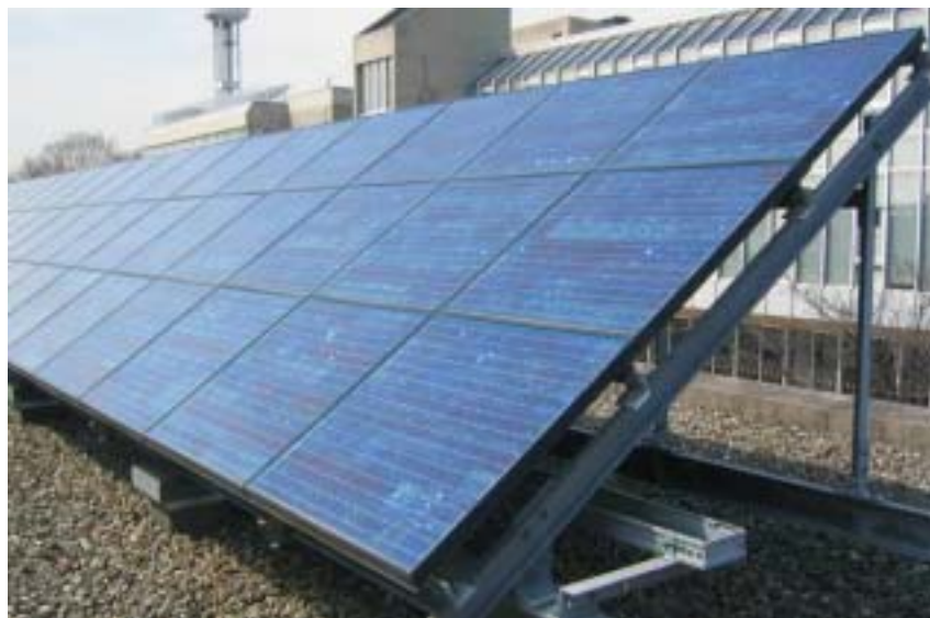
多結晶型太陽光パネル
