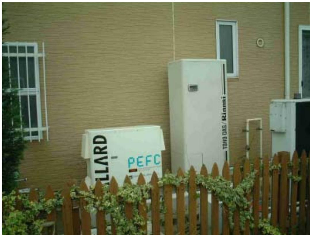
左：燃料電池本体、右：排熱利用給湯暖房システム
